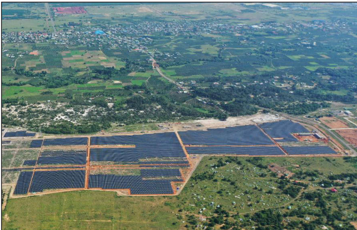
NHÀ MÁY ĐIỆN MẶT TRỜI HÀM KIỆM 1 - BÌNH THUẬN
