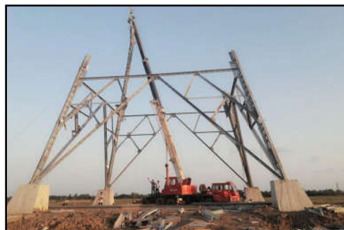
Thi công Đz 500kV Pleiku-Mỹ Phước-Cầu Bông
