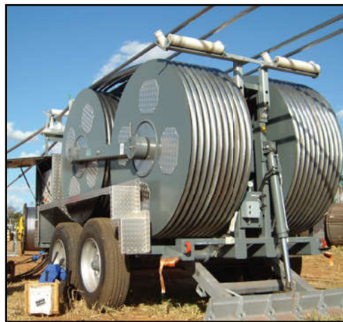
Thi công kéo dây 500kV
